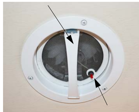
Fan Power Switch
